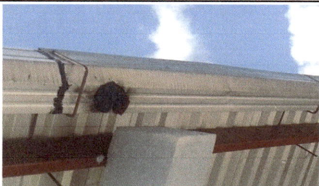
Foto 3: Reparacion de bajada de agua pluvial tubo pvc3
