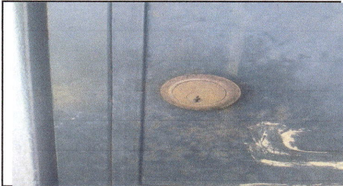
Foto1: Lijado y aplicación de pintura
