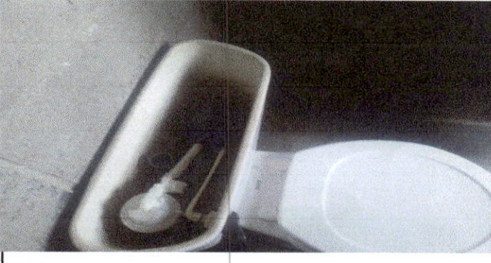
Foto 6: Instalacion de Inodoro
