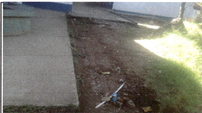
Foto 5: Reparacion de planchas de cncreto de patio
