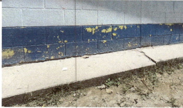
Foto 2 : Pintura en muros exteriores e interiores
